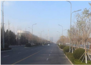
廊坊艺术大道西延段 TP-LINK助力打造高质量公路监控
